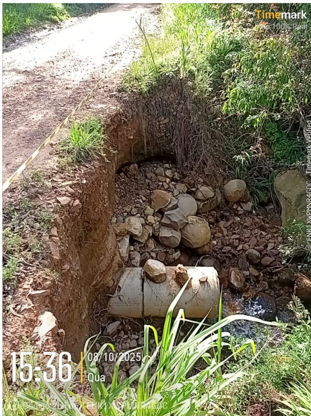
Imagem 4 – Construção de bueiro auxiliar – DN 800 mm.
