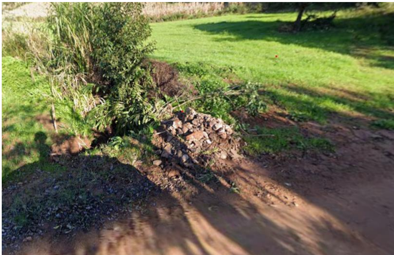
Imagem 2 – Construção de galeria com aduelas 1,5 m x 1,5 m.
