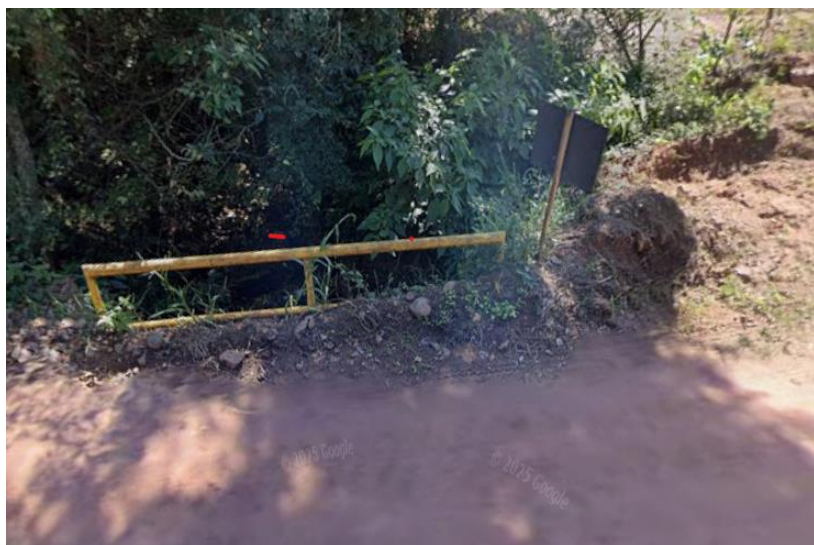
Imagem 11 – colocação de 2 aduelas 3x3 e cabeceira para aumento da galeria.
