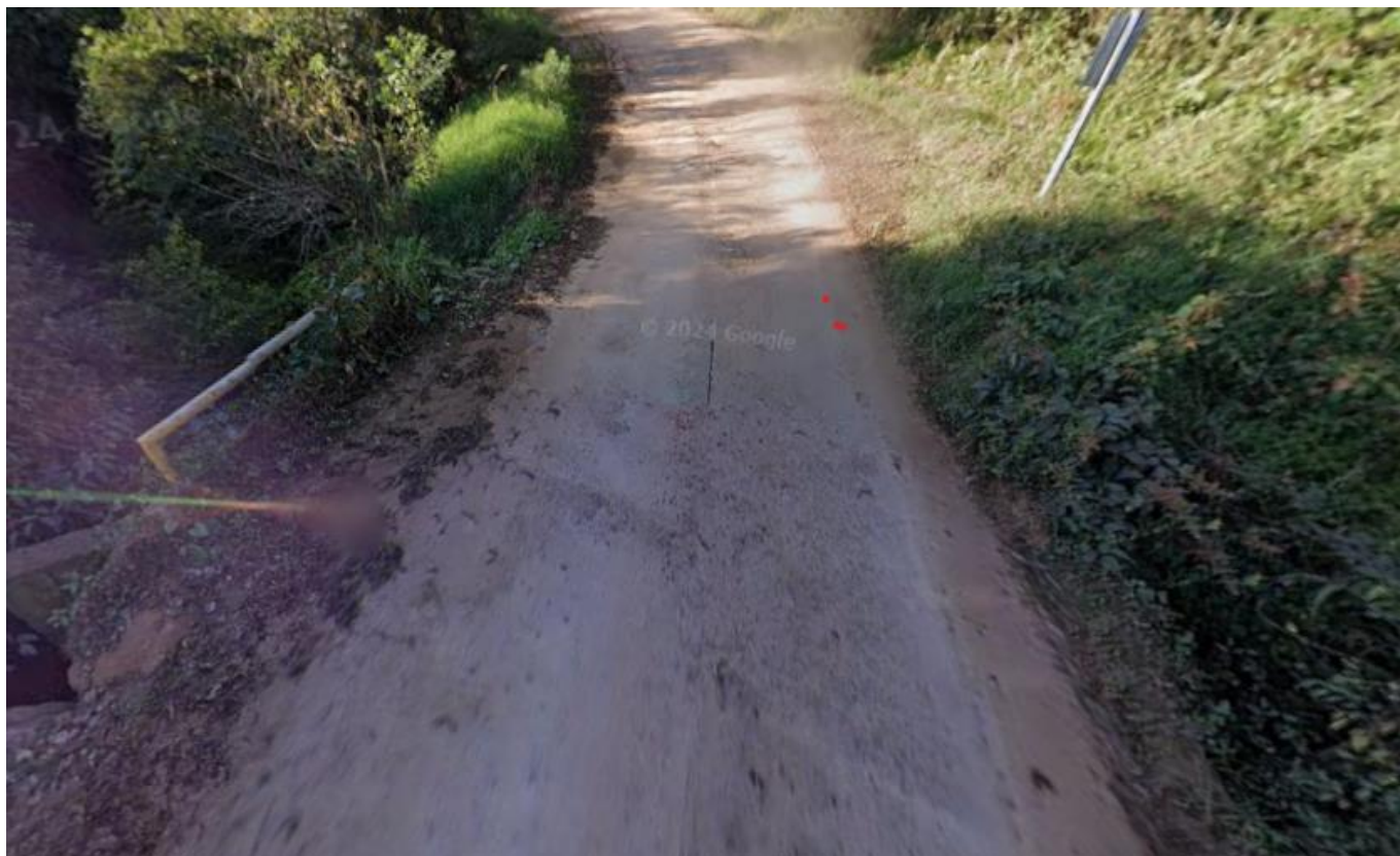
Imagem 10 – colocação de 3 aduelas 2x2 e cabeceira para aumento da galeria.
