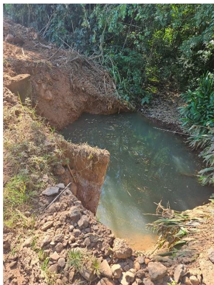
Imagem 9 – colocação de 3 aduelas 2x2 e cabeceira para aumento da galeria.
