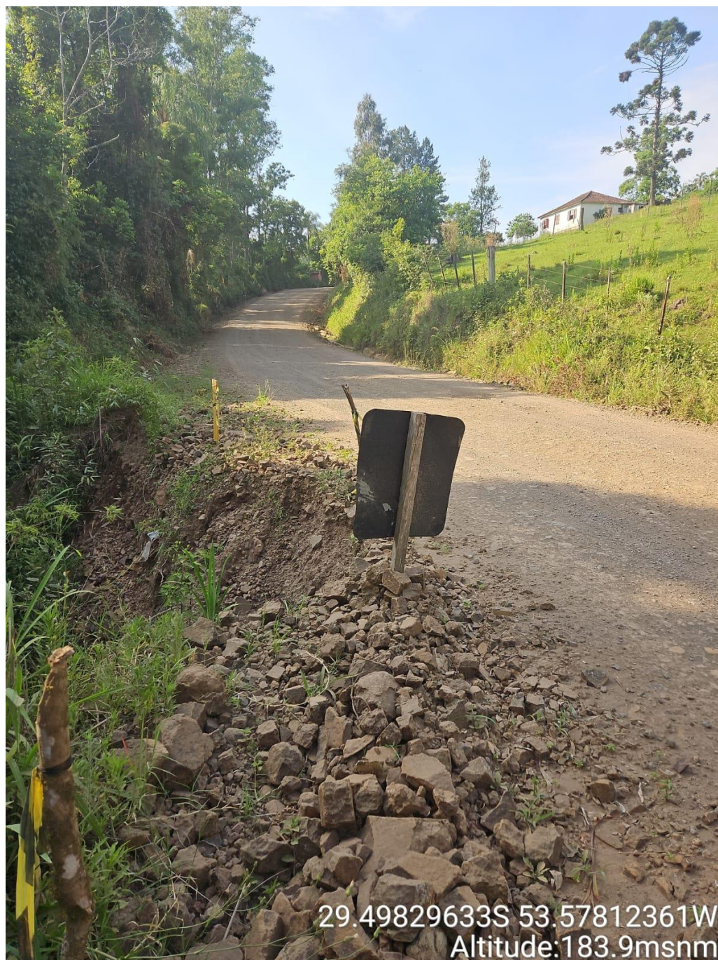
Imagem 6 – Construção de bueiro e cabeceiras – DN 1000 mm.
